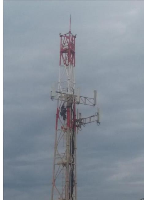
Le due antenne che assicurano il Servizio Radio Marittimo di TIM lavorano nelle bande di 1.605 kHz e 3.800 kHz. Trasmettono a orari prefissati e ascoltano le eventuali richieste di aiuto dalle imbarcazioni, entro un ampio raggio di copertura, senza l'impiego di satelliti artificiali. Si tratta di un'antenna a stilo e di un'antenna a cono.
